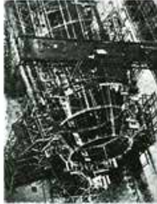
Entstehen einer Metallkonstruktion
